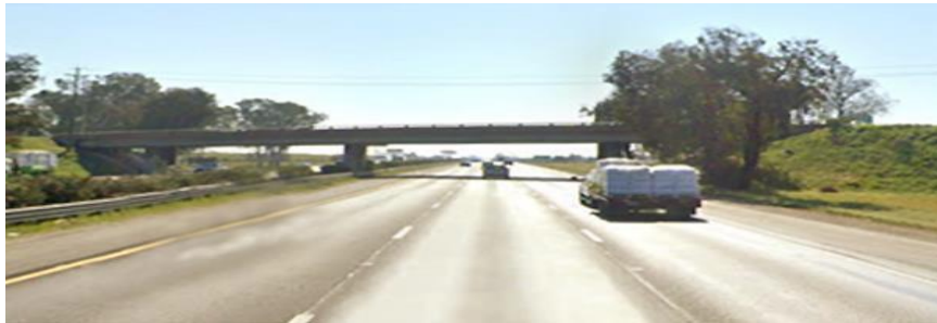
Vista sur de American Avenue sobre la ruta estatal 99
