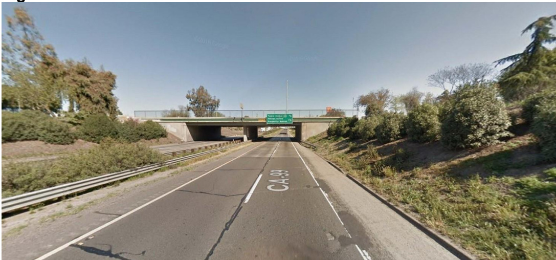
Figura 2-7 Condiciones existentes en la milla 28.5
