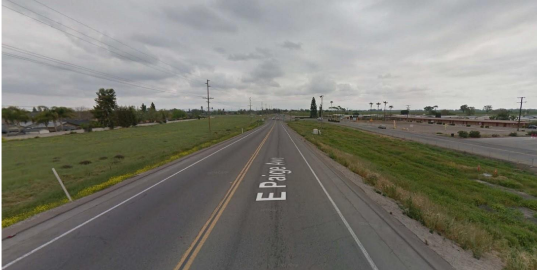
Figura 2-6 Condiciones existentes en Paige Avenue en el lado este de la ruta estatal 99, mirando hacia el este
